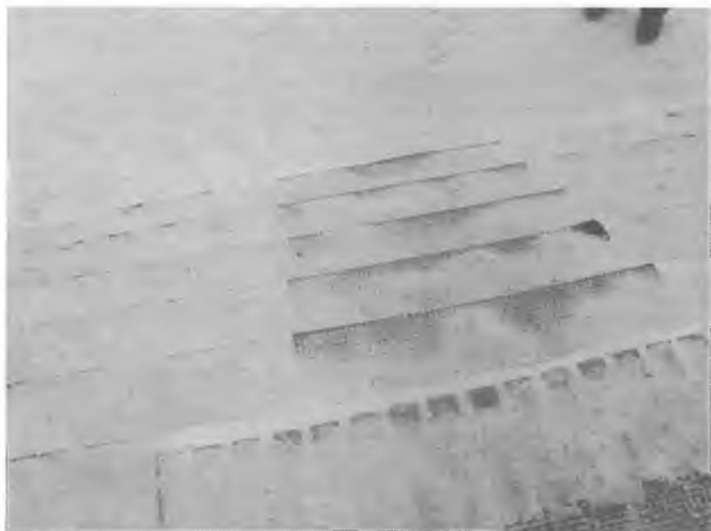
9. Лестница на территории (наружная)
