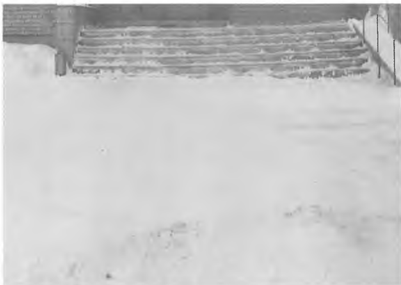
11. Лестница на территории (наружная)
